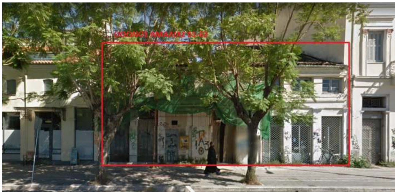
Εικόνα II.3. Όθωνος Αμαλίας 61-62 (Πηγή εικόνας πριν την επεξεργασία: Google maps – 28.05.2019)
